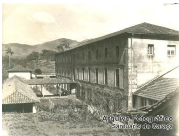
Foto 13. Prédio do Colégio
