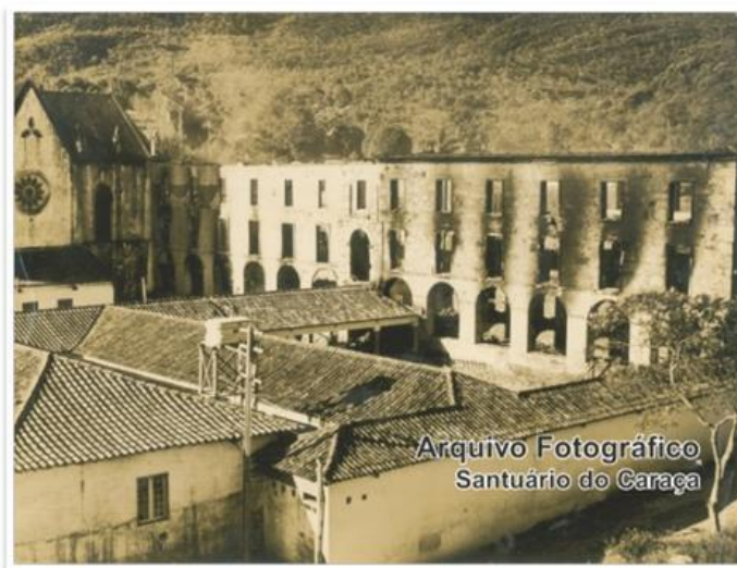
Foto 7. Prédio do Colégio incendiado. Ano de 1968.
